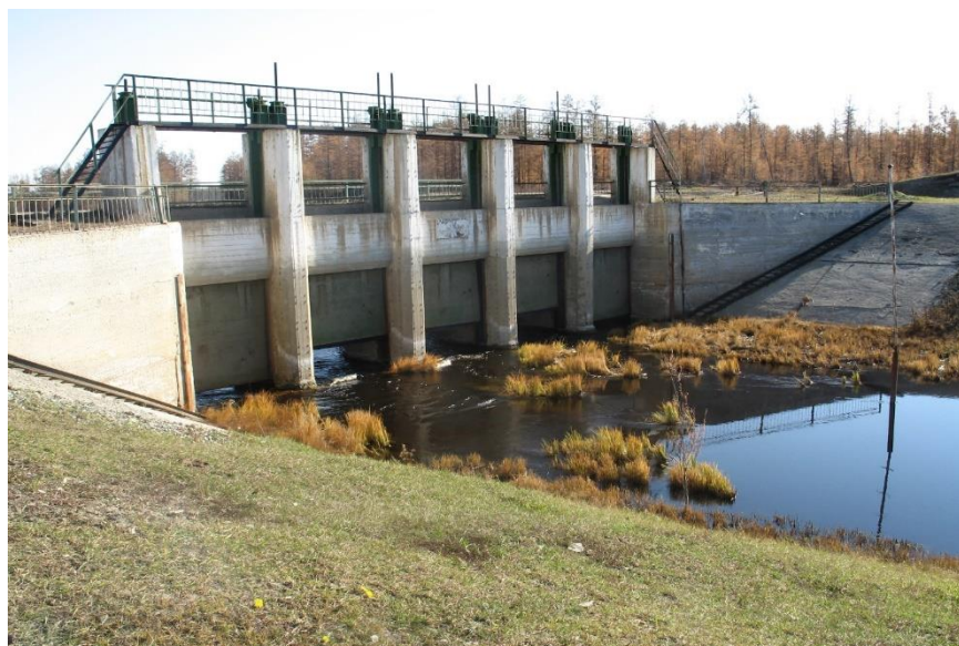
Рисунок 1. Водосбросной шлюз регулятор
