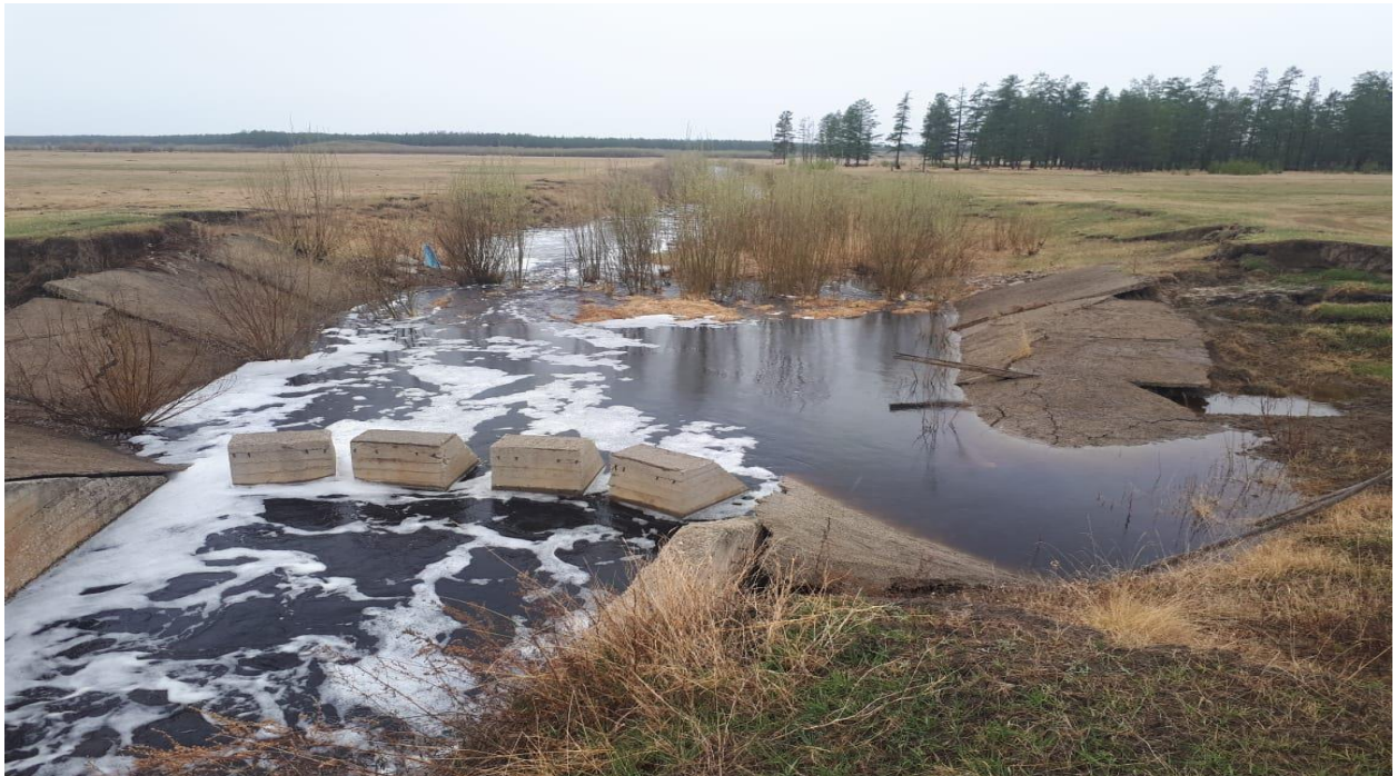
Рисунок 2. Внешний вид построенного сооружения со стороны нижнего бьефа
