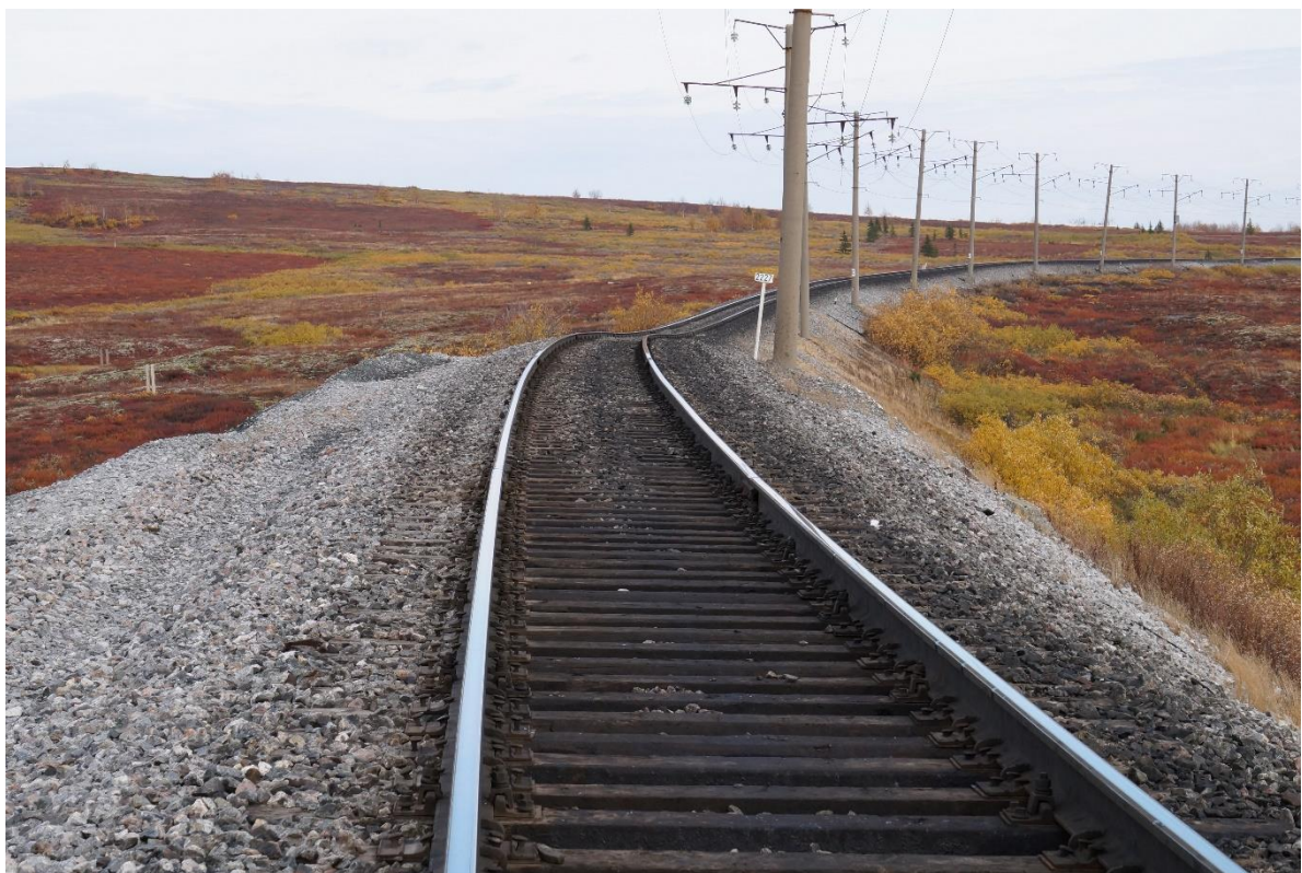
Рисунок 2 – «Волнистое» железнодорожное полотно с разными амплитудами просадок в районе ст. Песец [6]
