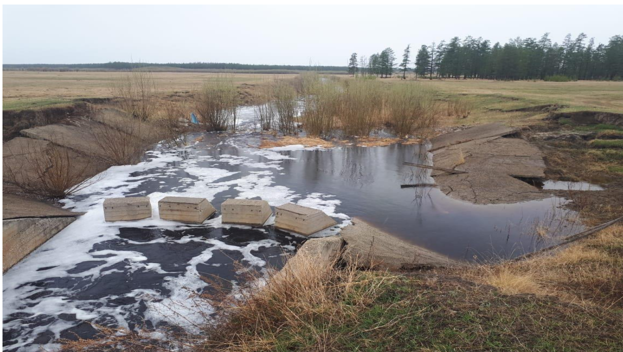
Рисунок 2. Внешний вид построенного сооружения со стороны нижнего бьефа
