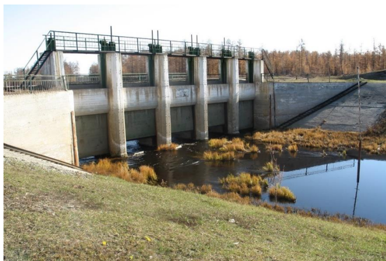
Рисунок 1. Водосбросной шлюз регулятор
