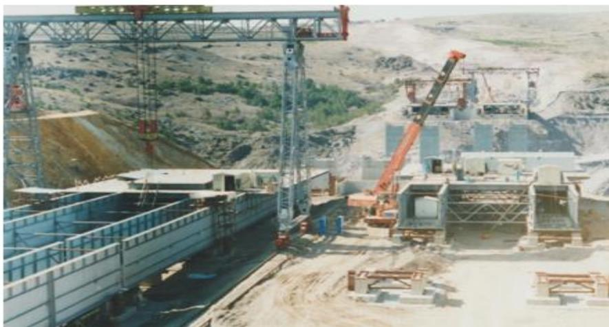
**Фото 2. Монтаж пролетных строений на противоположных берегах**
