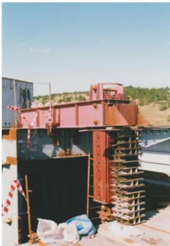
**Фото 4. Фиксирующее устройство и опорная клетка установки ПС в проектное положение**
