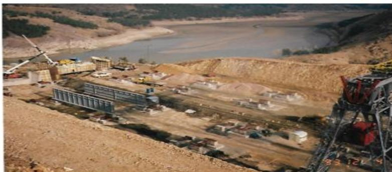
**Фото 1. Начало монтажа пролёта на стапельной площадке (мост Чубук)**
