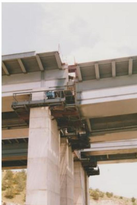
**Фото 3. Оформление стыка надвинутых пролетов моста Чубук (замок)**
